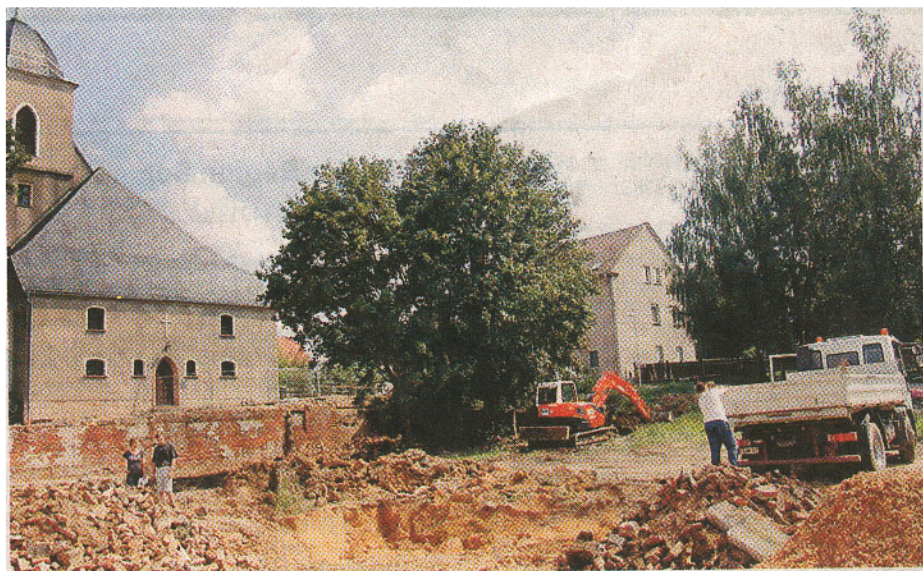
Zwischen Dorfplatz und Kirche in Zschernitzsch sieht es derzeit aus wie auf einer Großbaustelle – die Dorferneuerung hat begonnen. Foto: Christian Bettels
